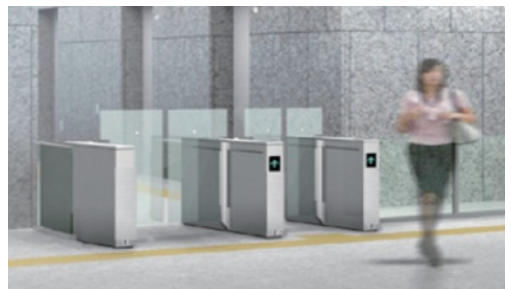
▲ICカードとゲートによるセキュリティシステム(東京都庁) 出典：東京都ホームページ
